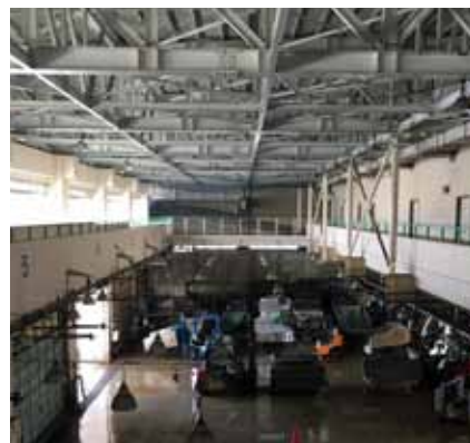
三浦市三崎水産物地方卸売市場
